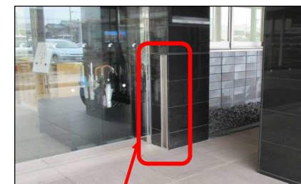
防水板設置用の 切り欠き(正面玄関)
