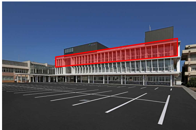
非常用発電設備を想定最大浸水深(1.87m)以上の3階に設置
