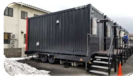
コンテナハウス
