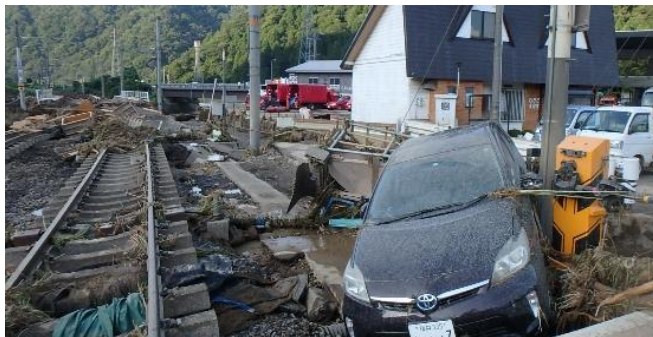
被災状況（南越前町）
