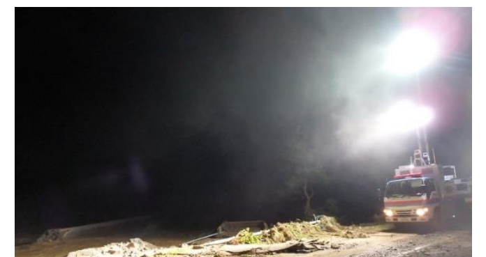
照明車の稼働状況（南越前町）
