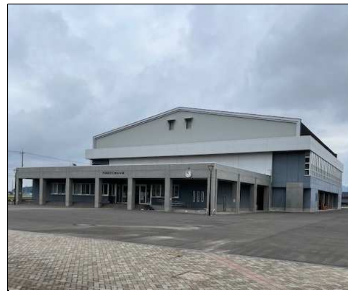
越前市余田町にある県有施設 丹南総合公園体育館
