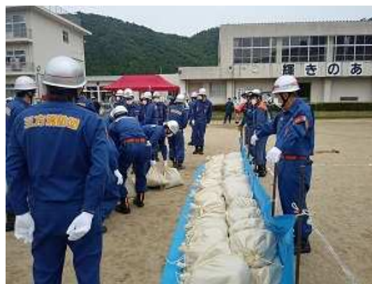
②改良積土のう工法Ⅰ型
