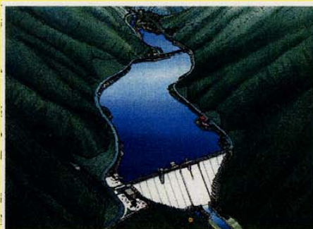
浄土寺川ダム
