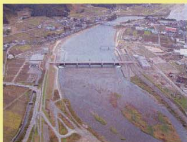
建設中の鳴鹿大堰
