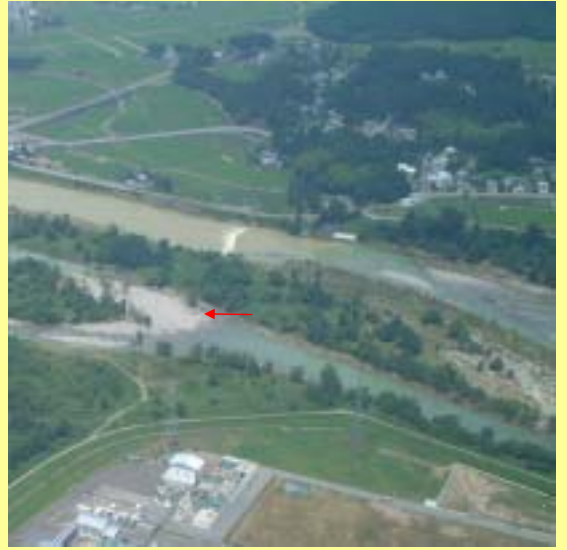
床止め工(壁倉)
