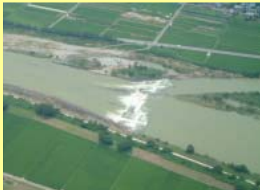
床止め工(谷口)
