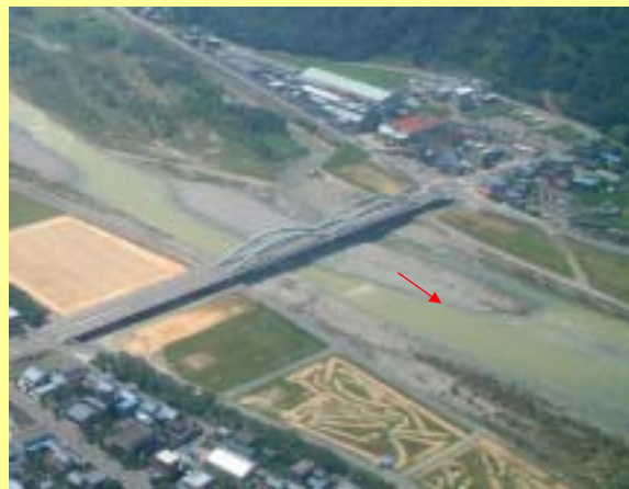
床止め工(勝山橋)
