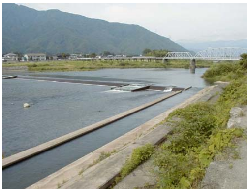
小舟渡取水堰（上志比村小舟渡付近）
