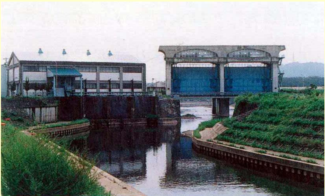
荒川ポンプと水門(荒川側より望む)
