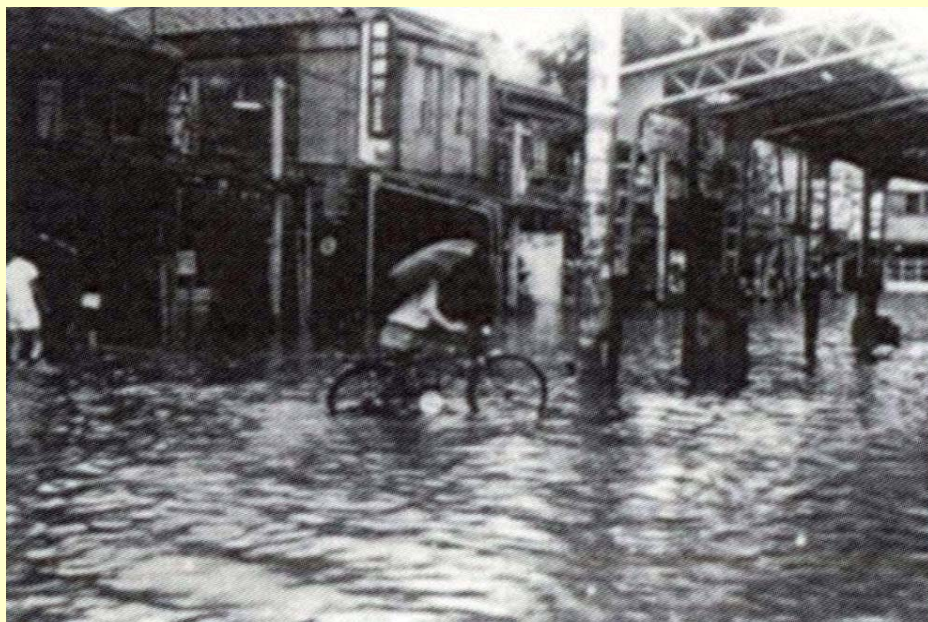
足羽川流域（福井駅前付近） 昭和34年8月12日 出水
