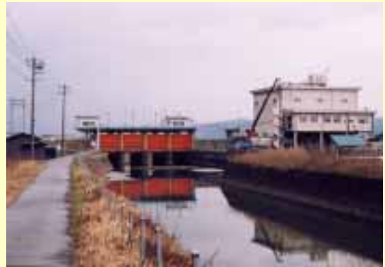
黒津川排水機場と樋門
