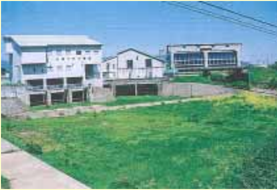
江端川排水機場と樋門
