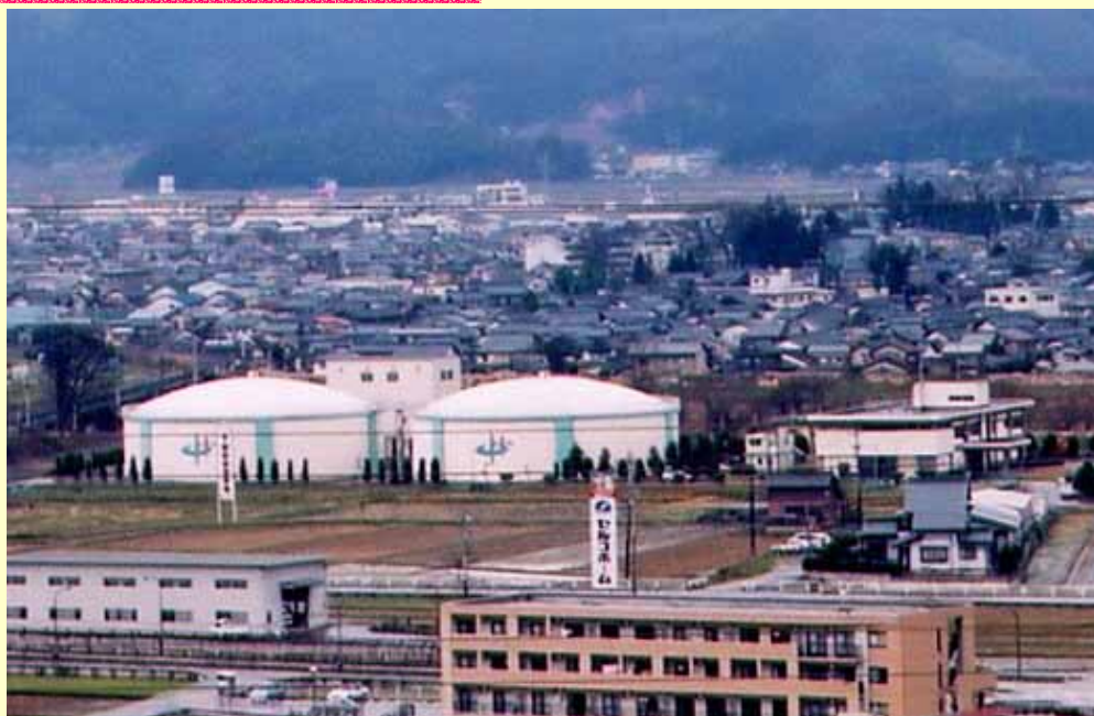
鯖江市上水道管理センター
