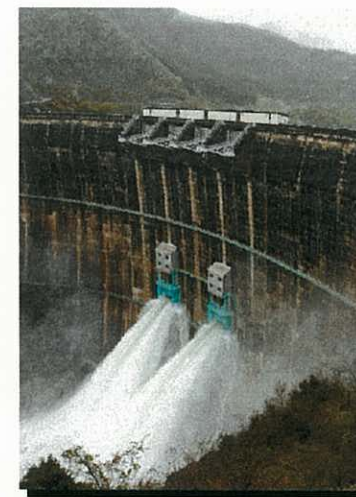
◇九頭竜川鳴鹿大堰
