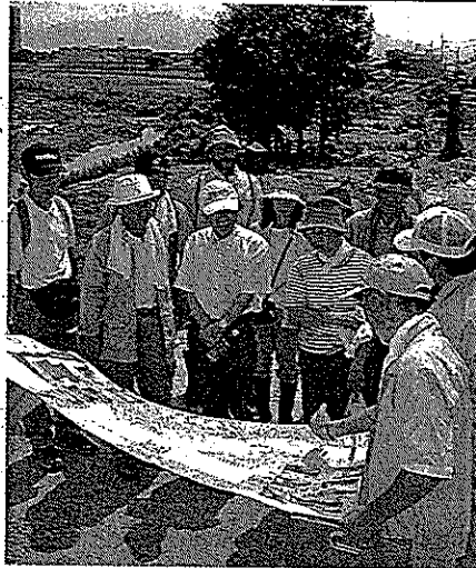
足羽川堤防の決壊現場を視察する委員たち。福井市春日1丁目
