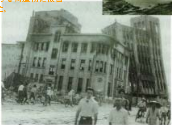
福井のシンボル大和百貨店の崩壊状況
