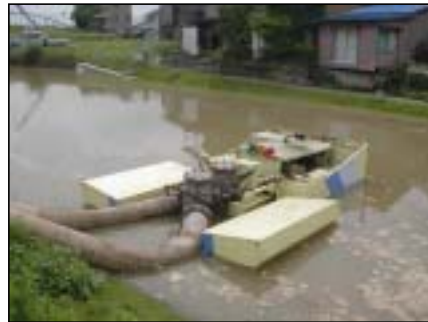
写真 福井市内での内水排除作業 (H16.5.17撮影)
