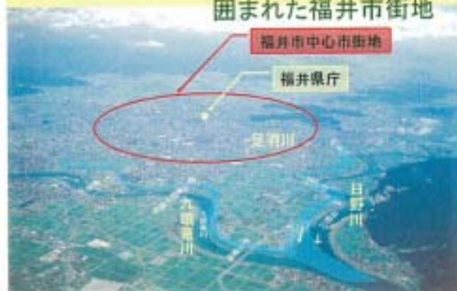
図1.6 九頭竜川・日野川・足羽川に囲まれた福井市街地
