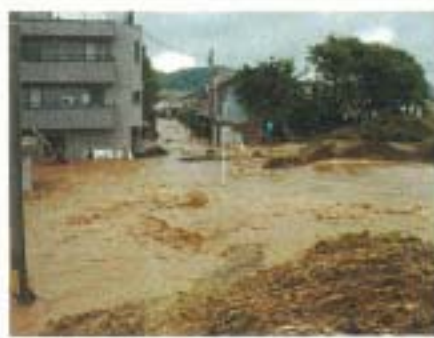
足羽川が破堤(福井市木田地先)
