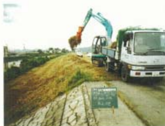
図4.33 除草後の積み込み作業
