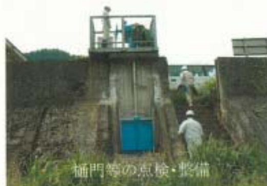
図4.38 樋門の点検・整備
