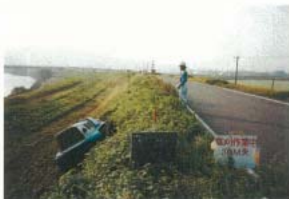
図4.32 出水期、台風期前に堤防等の除草を実施
