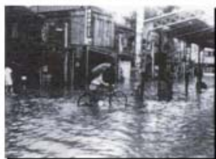
足羽川流域(福井駅前付近) 昭和34年8月12日 出水
