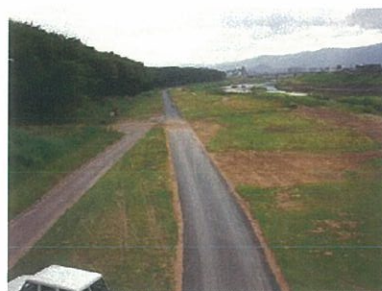
工事後(平成17年6月現在)
