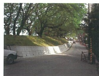
工事後(平成17年6月現在)
