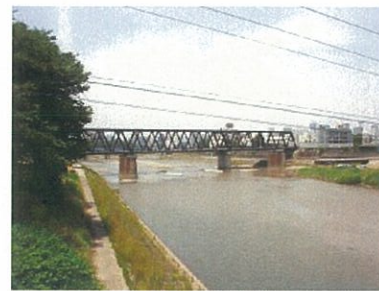
工事後(平成17年6月現在)
