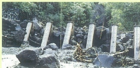
巨礫捕捉状況(事例)
