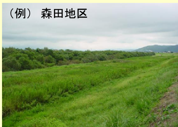
樹林化によって川面が見られない
