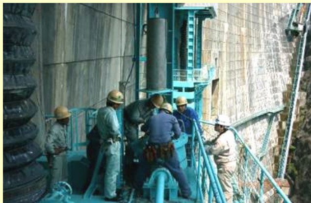
ダム放流設備点検
