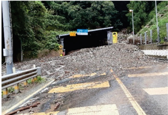
国道8号 上下線：南越前町鱒橋交差点～敦賀市大比田交差点 【8/9 片側交互通行規制、8/20 規制解除】
