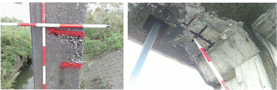
樋門本体の老朽化(九頭竜川 許可工作物)
