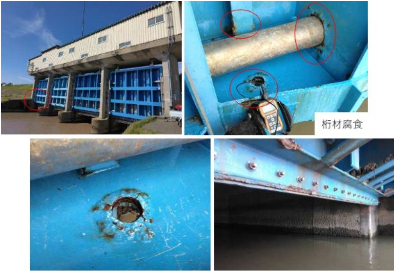
樋門ゲートの老朽化(片川放水路樋門4号ゲートの腐食)
