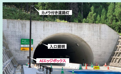
大野油坂道路下山トンネルに導入
