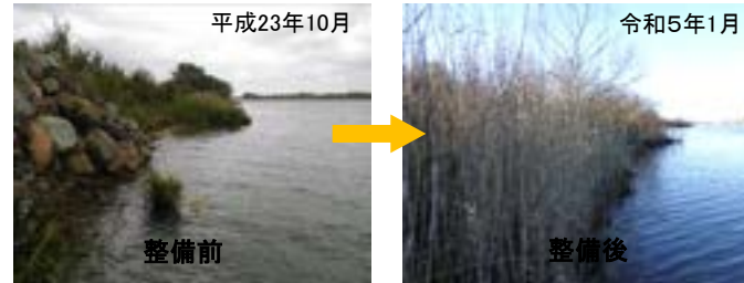
水際の再生状況(三宅地区)
