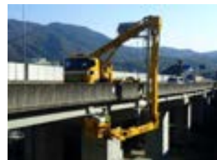
橋梁点検車を用いた点検状況
