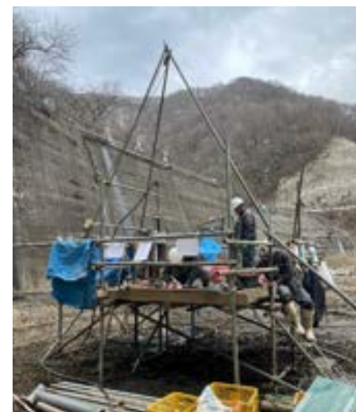
地質調査の状況（令和5年撮影）
