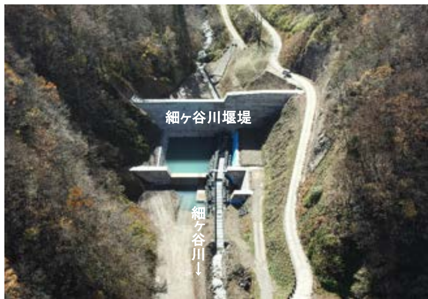
細ヶ谷川堰堤（令和5年12月時点）
