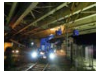
橋梁点検状況(鉄道を跨ぐ橋梁部)
