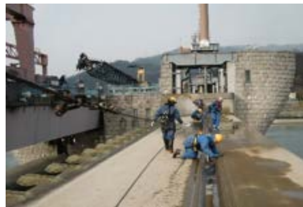
主ゲート扉体点検の様子
