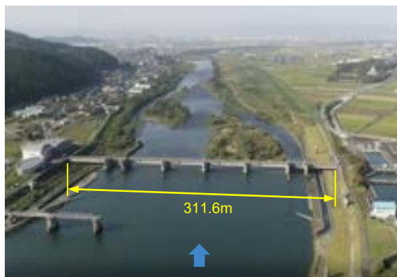
九頭竜川鳴鹿大堰(下流を望む)
