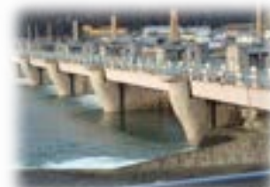
九頭竜川鳴鹿大堰
