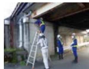
職員による直営診断状況
