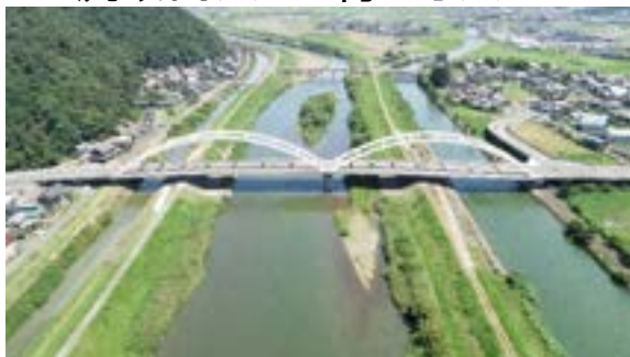
北川下流部(水取地区付近)
