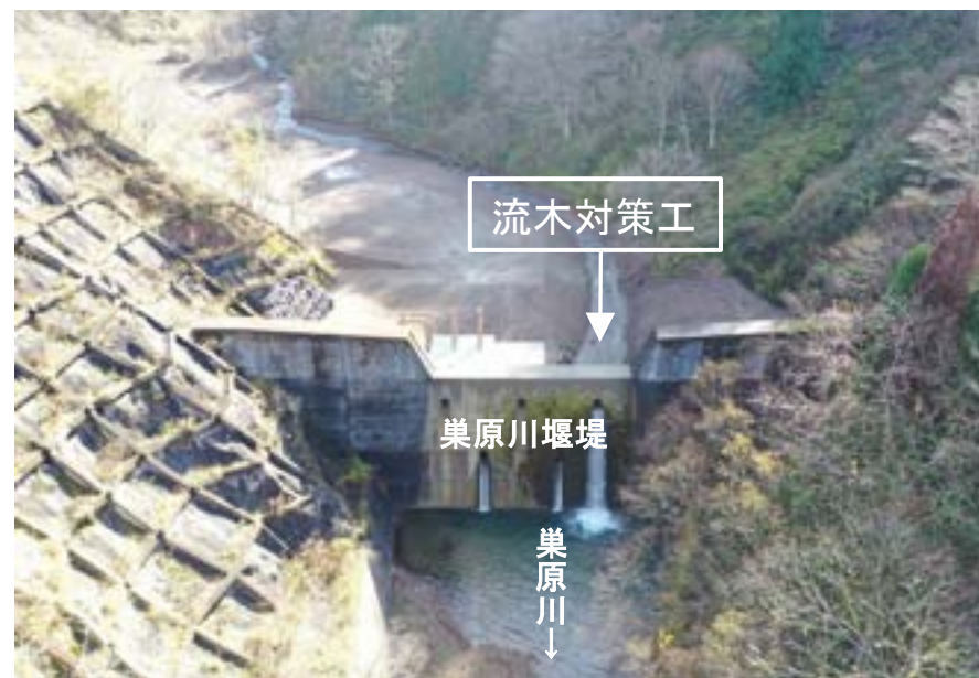
巢原川堰堤改築（令和5年12月時点）
