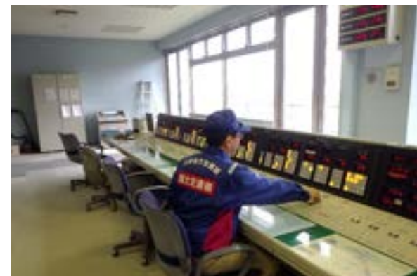
堰の操作システムの点検の様子
