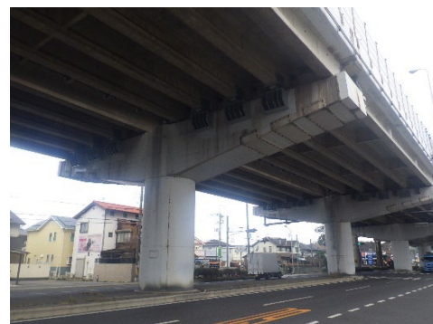
橋梁の耐震補強工事(曾根高架橋)
