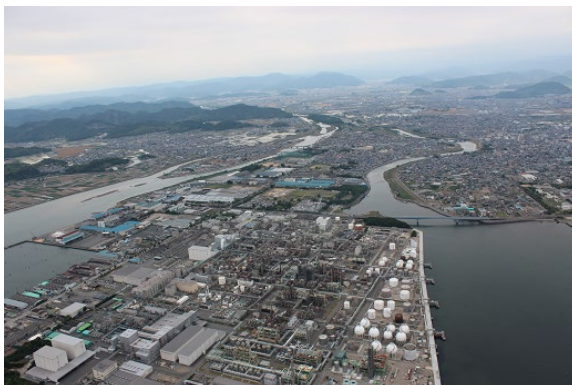
揖保川河口部から 三川分派を望む
