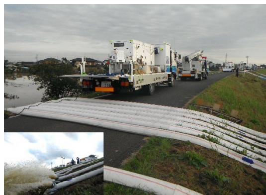
排水ポンプ車による排水作業
