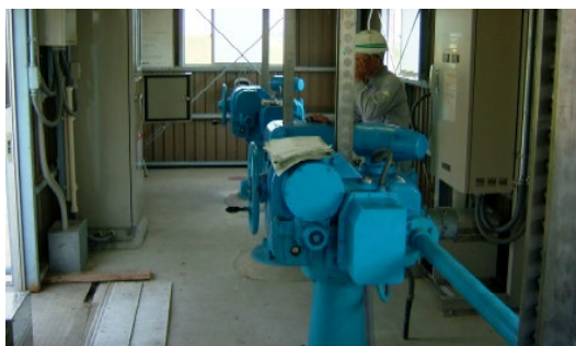
樋門施設の保守
