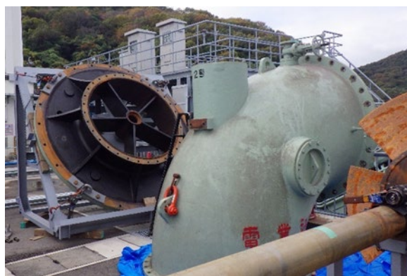
ポンプ解体整備状況
