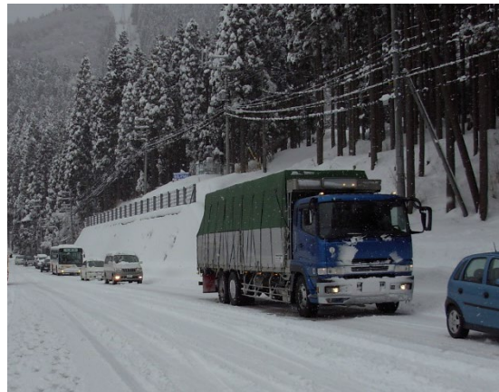
積雪時の状況（ しろうしはがちょうとくら 宍粟市波賀町戸倉地先）
