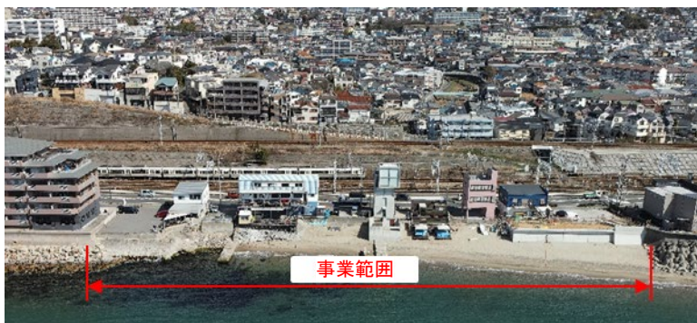
事業箇所(狩口地区)
