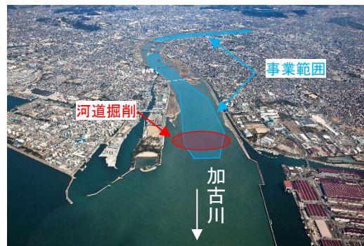
河道掘削箇所 (高砂他地区)
