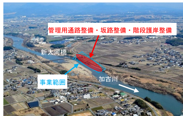
整備箇所(加古川 24.6k~25.0k 付近)
