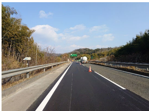
姫路西バイパス 舗装補修後
