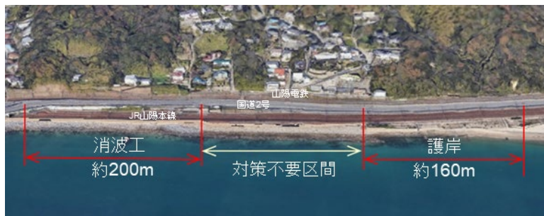
護岸整備箇所(塩屋東地区)
