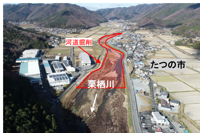
河道掘削箇所（大屋地区）
