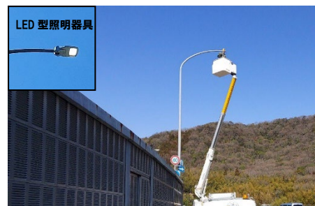
LED 型照明器具の取替工事
