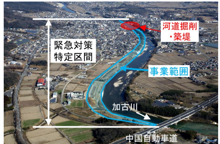
河道掘削・築堤箇所（滝野地区）
