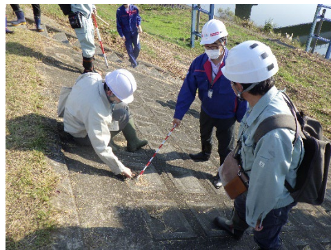
堤防点検(護岸調査)
