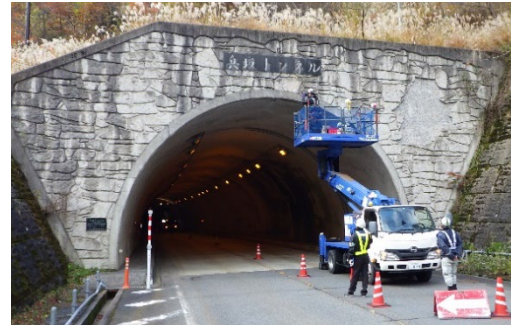
トンネル点検状況
