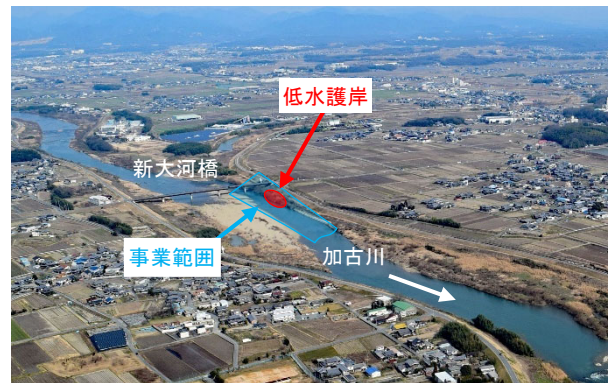
整備箇所(加古川 24.6k~25.0k 付近)
