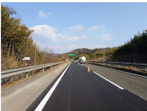
姫路西バイパス 舗装補修後
