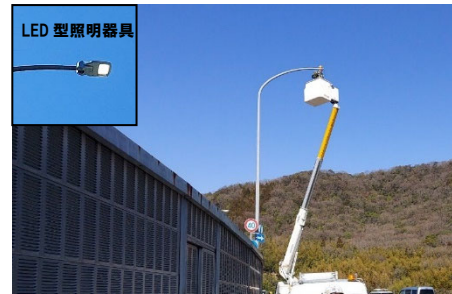
LED 型照明器具の取替工事
