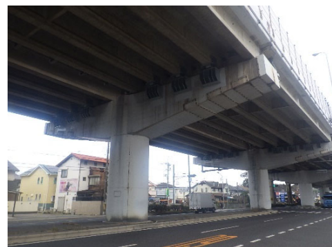
橋梁の耐震補強工事(曾根高架橋)
