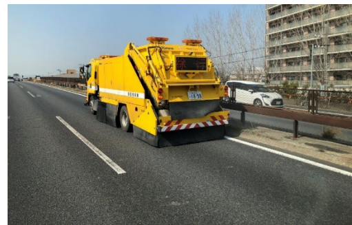
路面清掃状況
