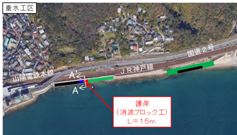
護岸整備箇所(塩屋東地区)
