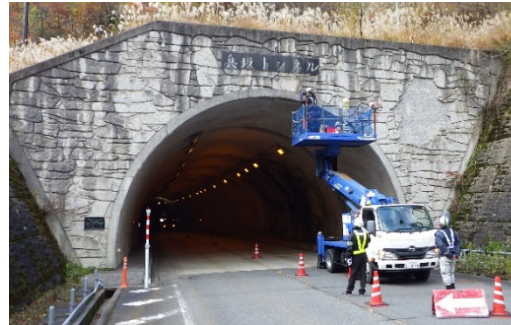
トンネル点検状況
