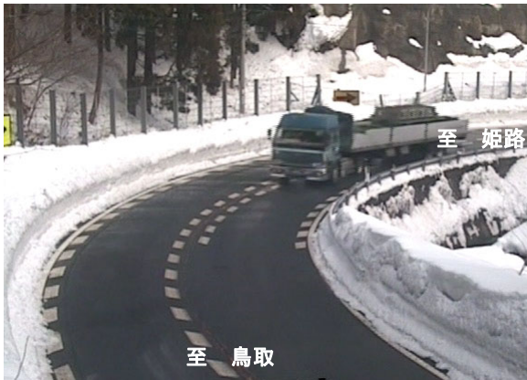
線形不良箇所(宍粟市波賀町戸倉地先)
