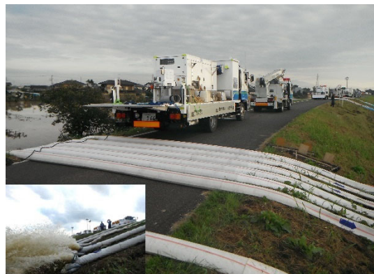
排水ポンプ車による排水作業
