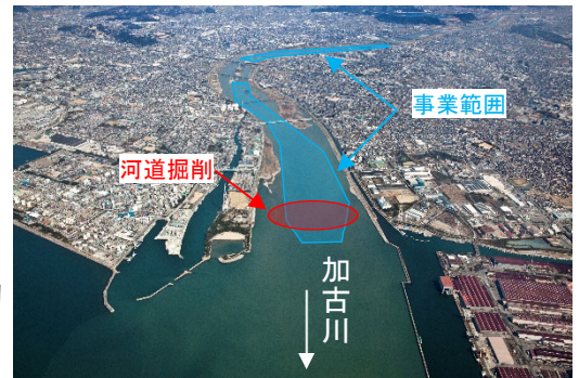
河道掘削箇所 (高砂他地区)
