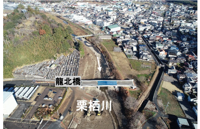
橋梁架替実施状況(新宮地区)(令和8年1月時点)
