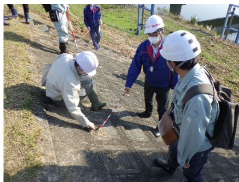
堤防点検(護岸調査)
