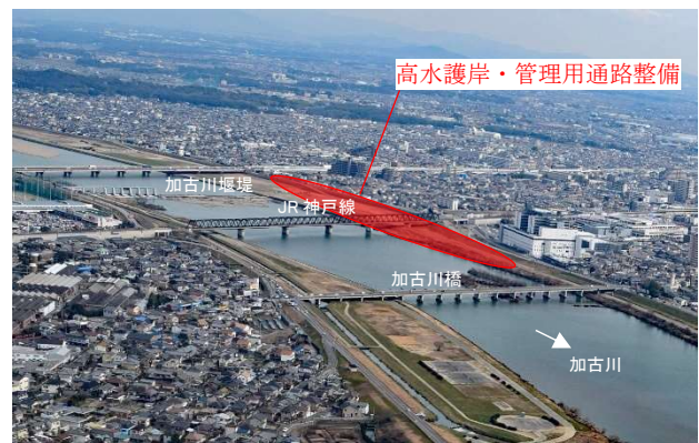
整備箇所(加古川 5.6k~6.4k 左岸付近)
