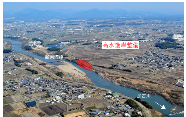
整備箇所(加古川 24.6k～25.0k 付近)
