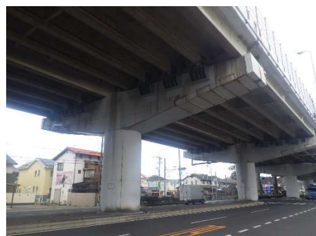
橋梁の耐震補強工事(曾根高架橋)
