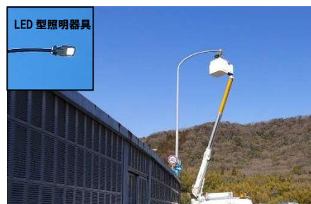
LED 型照明器具の取替工事
