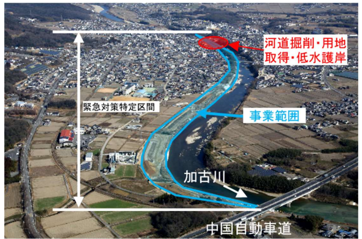
河道掘削・築堤箇所（滝野地区）
