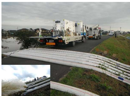
排水ポンプ車による排水作業
