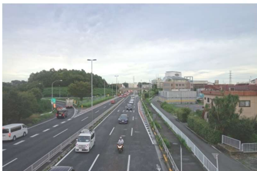
姫路バイパス 舗装補修後
