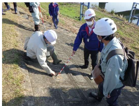
堤防点検(護岸調査)
