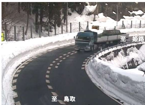
線形不良箇所 しそ (宍粟市波賀町戸倉地先)
