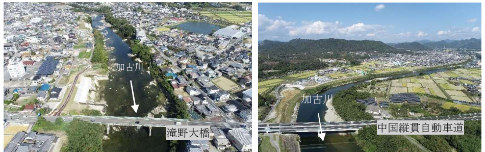
築堤等実施状況(滝野地区)(令和6年1月時点)
