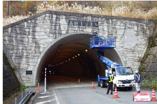
トンネル点検状況
