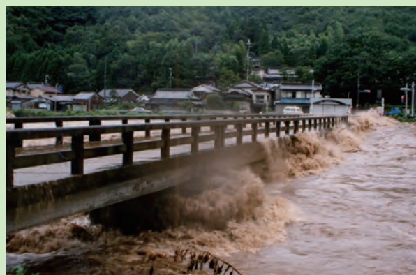
兵庫県宍粟市山崎町 旧神河橋付近
