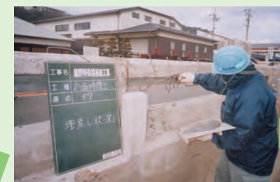
3.モルタルやパテ材を塗って、表面の凹凸を滑らかに
