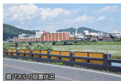
畳パネルの設置状況
