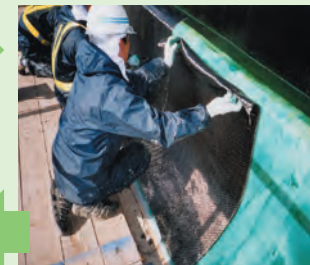
4.コンクリート劣化防止に炭素繊維シートを貼る
