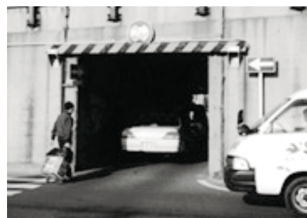
ボックスの現況
