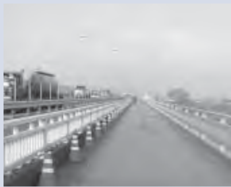
拡幅したアルミ床板の新設副道
