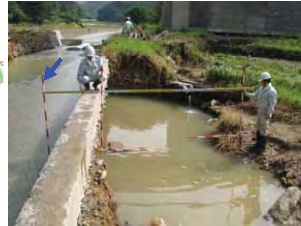
越水による護岸背面の侵食
