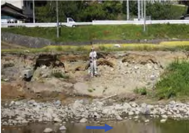
流水による護岸の崩壊
