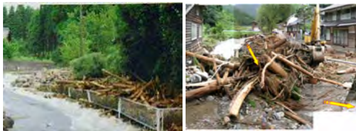
< 流木等による下流での被害 >
