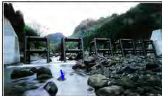
鋼製透過型の砂防えん堤・治山ダムを整備
