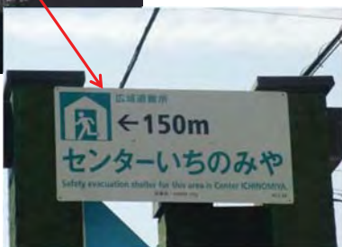
見やすさを考慮し、 高い位置に設置した 標識
