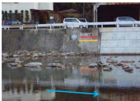
設置した自主避難の目安線
