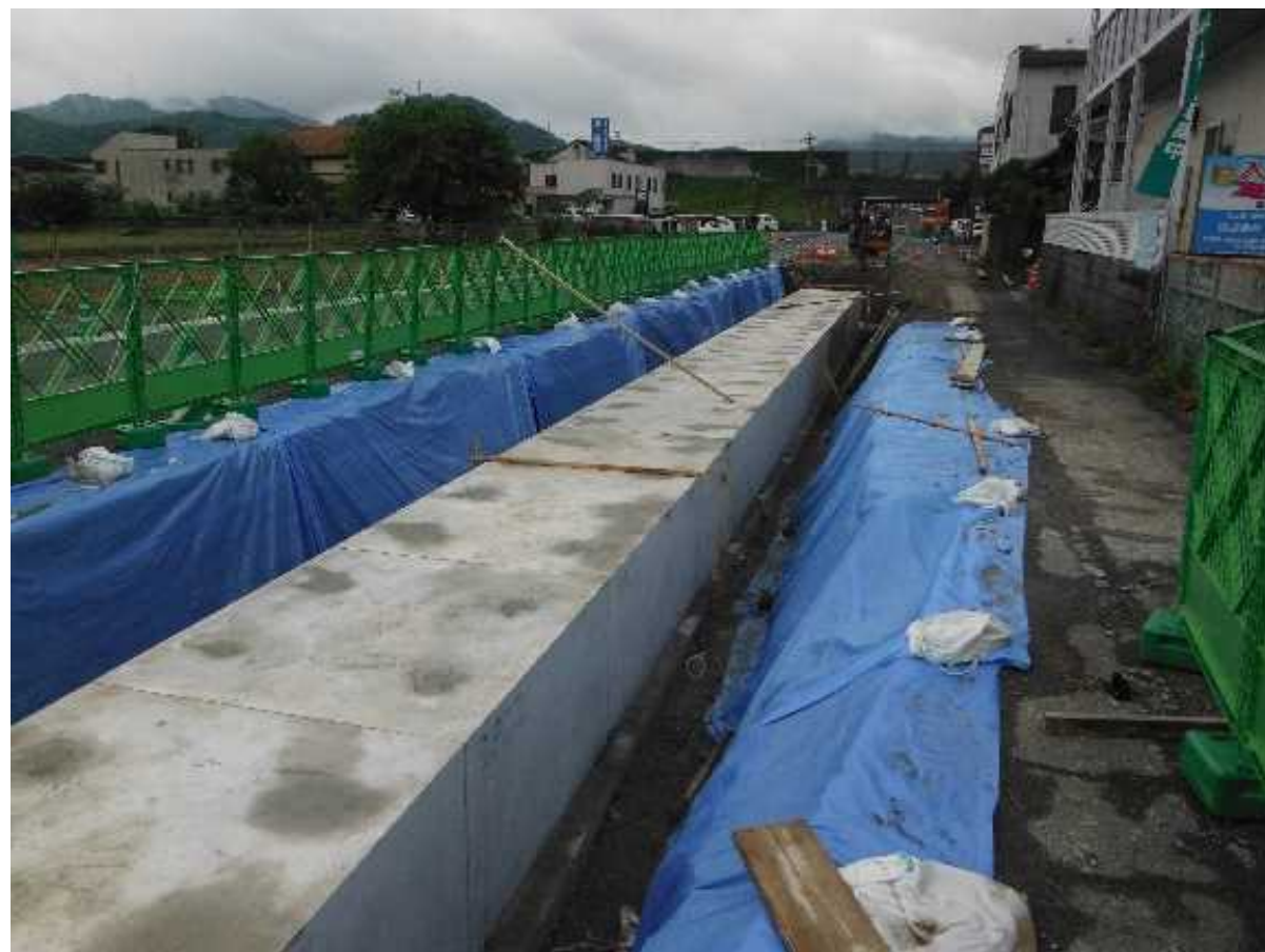
工事中の幹線排水路
