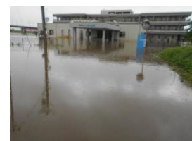
浸水時の状況 (喜多方市提供)
