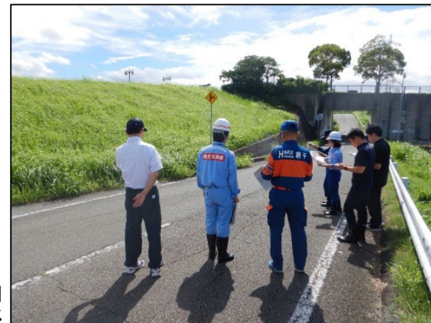
揖保川右岸2.2k付近 【姫路市との共同点検状況】 基礎地盤漏水
