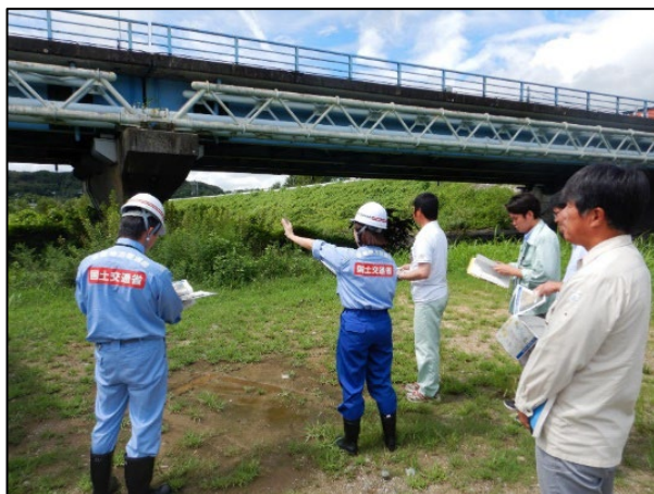
揖保川右岸11.8k付近 【たつの市との共同点検状況】 龍野新大橋
