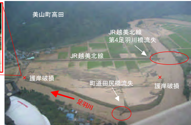
足羽川が越水し、堤内地を流下 美山町高田上空（18日撮影）
