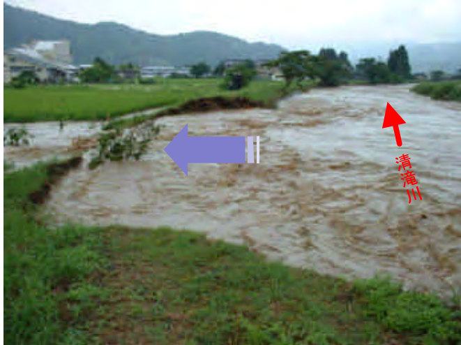
清滝川左岸が破堤 大野市友江（18日撮影）
