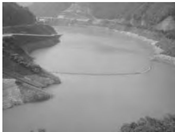
図4.4.6 網場設置の様子（大滝ダム）
