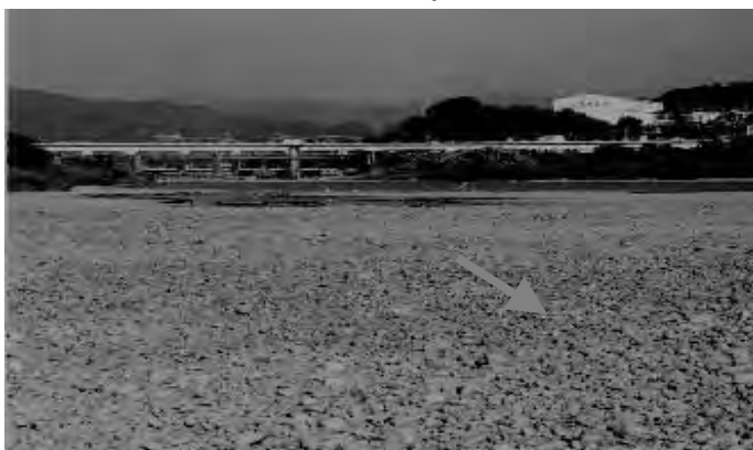
図2.2.4 紀の川の瀬切れの様子 (船戸下流 (平成13年))
