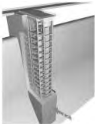
図2.4.12 大滝ダム-選択取水設備
