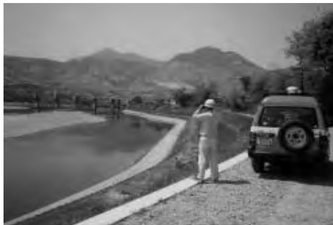
図4.4.10 河川巡視の様子
