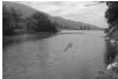
図2.3.2 堰(藤崎井堰)の湛水区間
