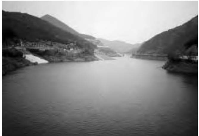
図2.3.13 北塩谷橋下流（大滝ダム）
