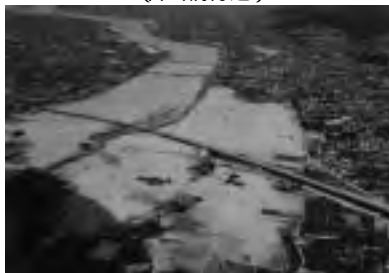
図1.10 昭和57年台風10号による被害状況 (和歌山市直川地区)
