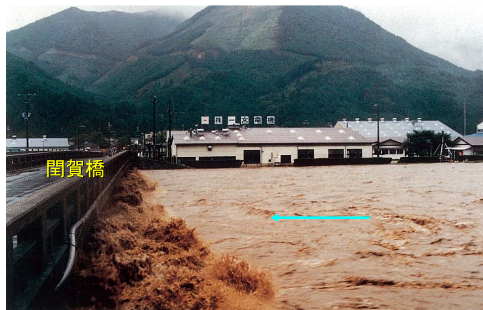
閨賀橋上流より
