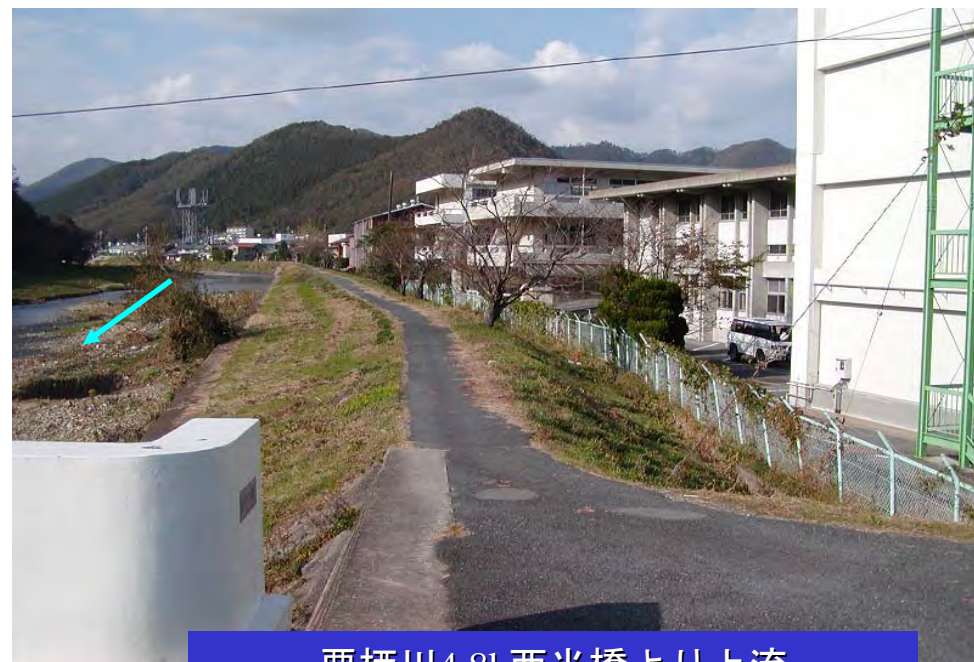
栗栖川4.8k西光橋より上流
