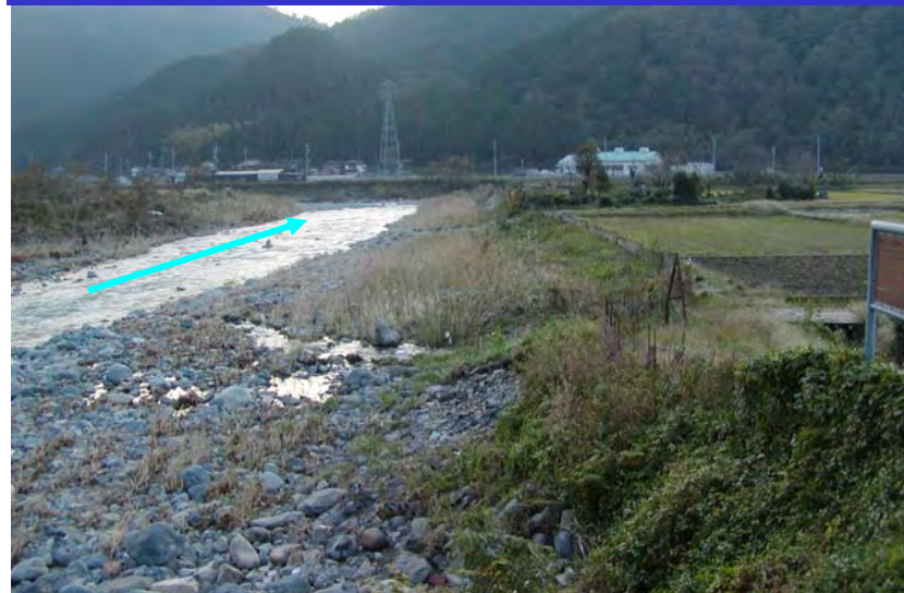
右岸45.0k付近（安積橋右岸橋詰）より下流
