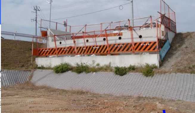
右岸本町橋新橋A 2 橋台
