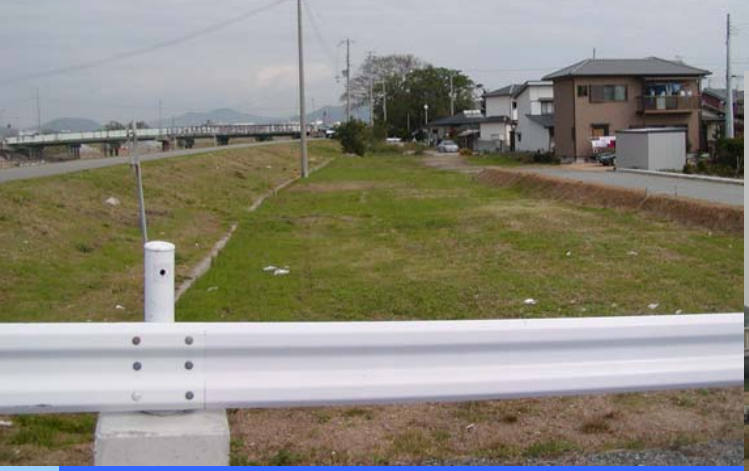
左岸0.4k 付近より上流（引堤予定地近景）
