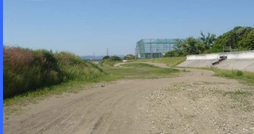
施工途中の高潮堤
