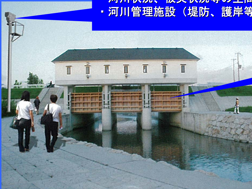
樋門付近のCCTV監視カメライメージ図
