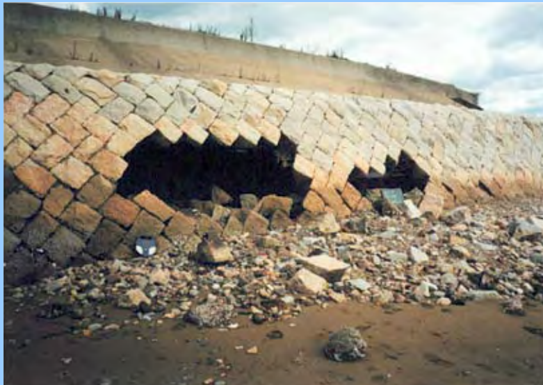
【護岸の補修前】
