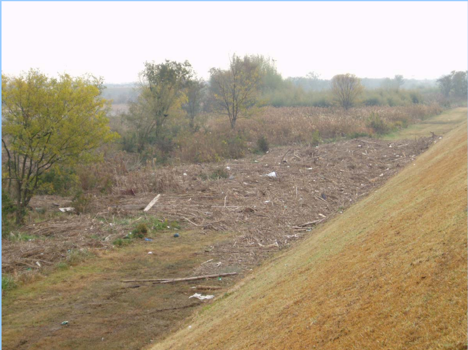
出水後のゴミの堆積状況
