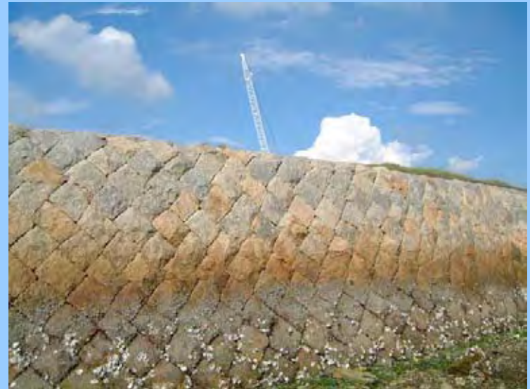
【護岸の補修後】
