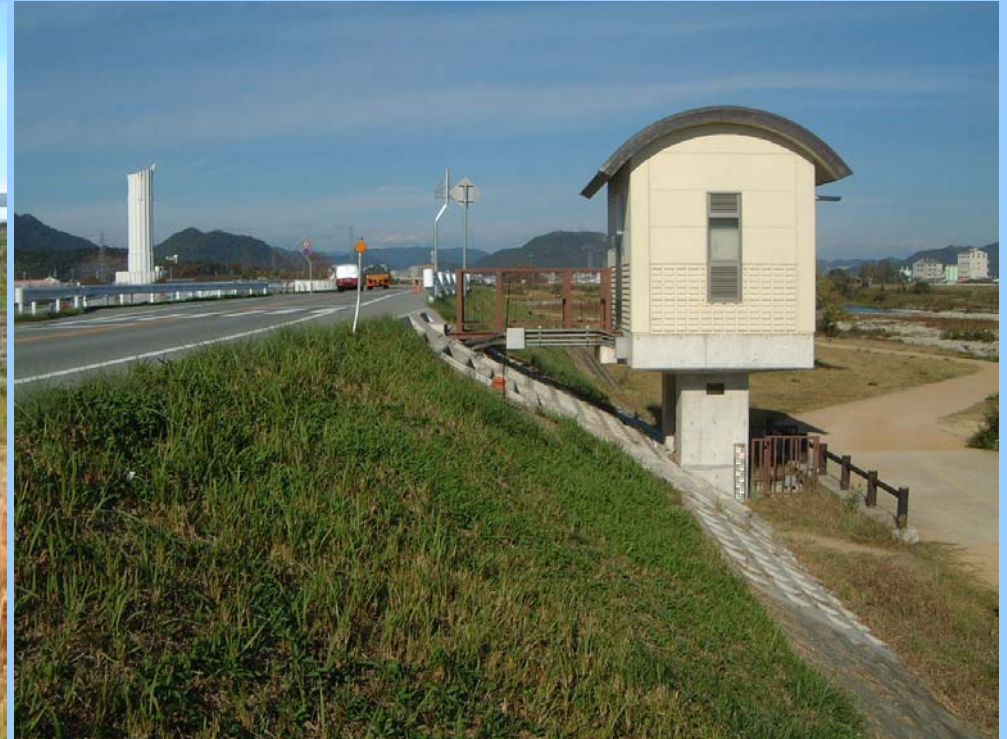
野田排水樋門
