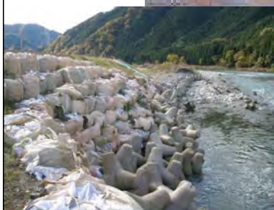
堤防欠損緊急復旧状況
