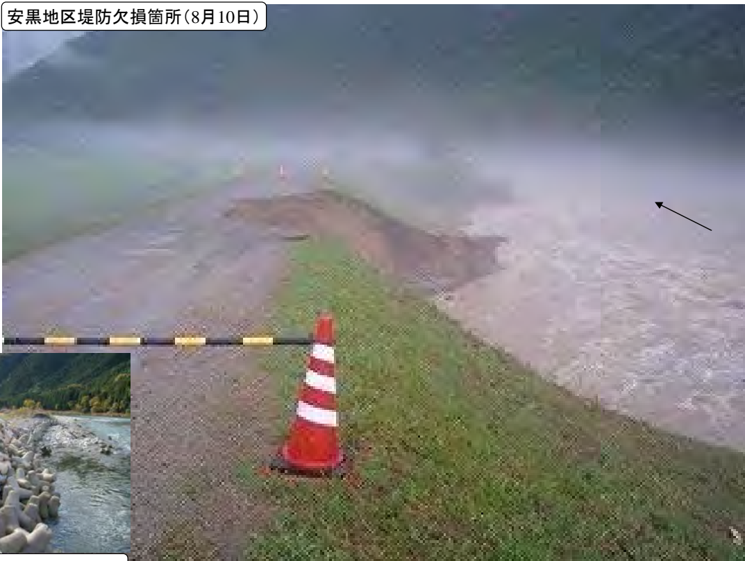
堤防欠損緊急復旧状況
