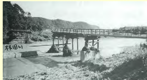
林田川入野橋流失(たつの市神岡町) S51.9洪水 被害状況
