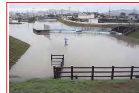
図-2.1.12 平成16年9月 台風21号による蟠洞川内水状況(姫路市余部区下余部)
