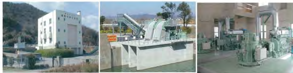
図-2.1.10 馬路川排水機場
