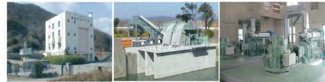
図-2.1.10 馬路川排水機場
