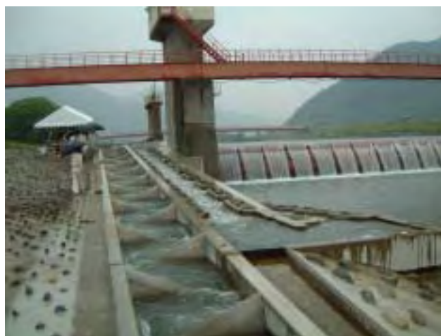
魚道の例(吉島統合頭首工)
