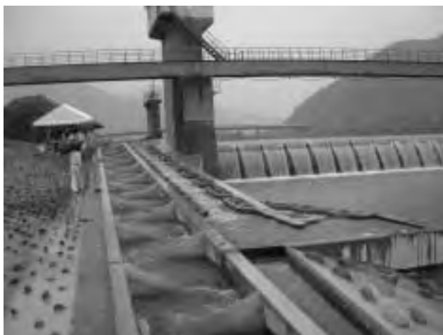
魚道の例(吉島統合頭首工)
