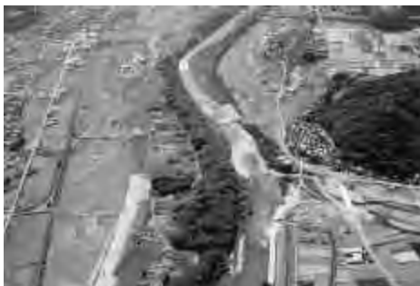
築堤整備状況 綾部市状況
