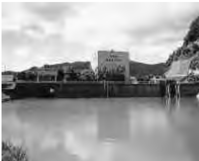
荒河排水機場
