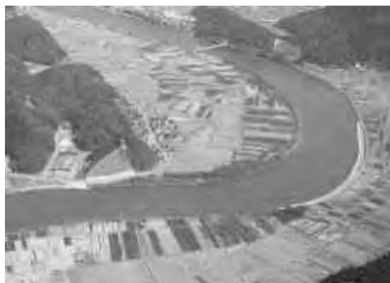
下流部の現状
