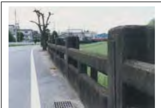
《畳堤 出典：揖保川流域委員会ホームページ 現地視察の概要 龍野橋付近(龍野市)より》
