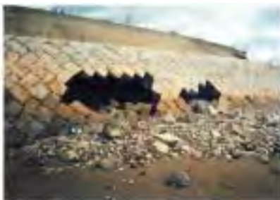
【護岸の補修前】
