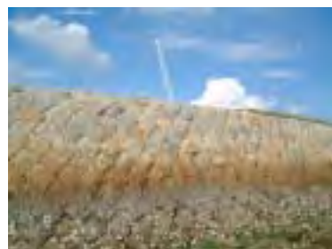
【護岸の補修後】
