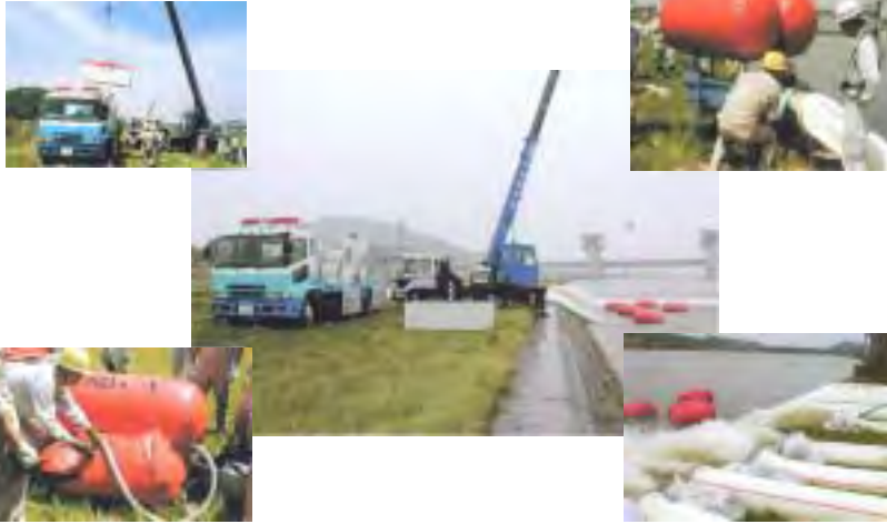
写真は加古川 車両は姫路河川国道事務所
