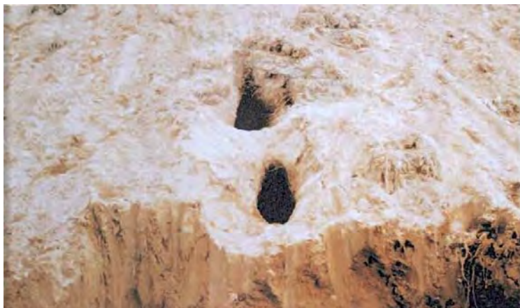
【堤防に掘られた穴】
