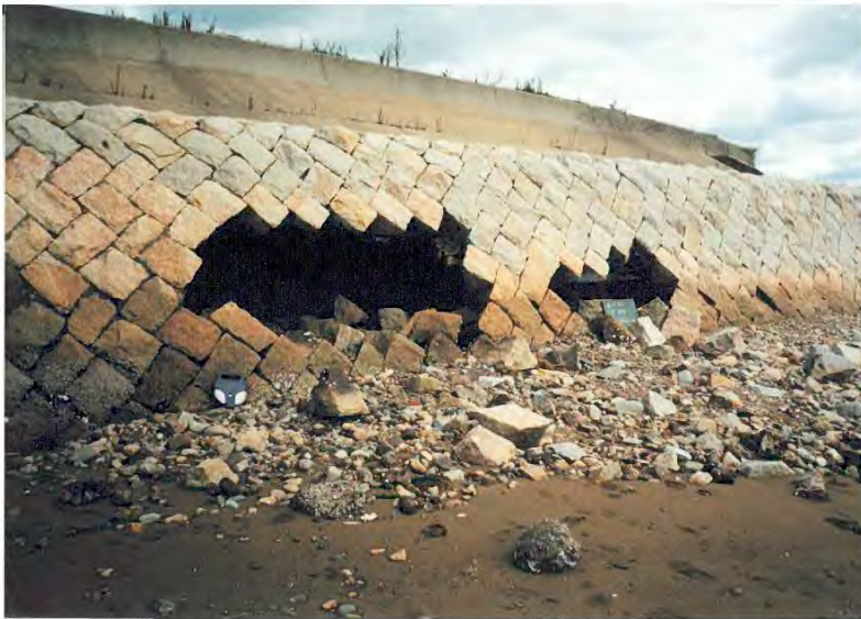
【護岸の補修前】
