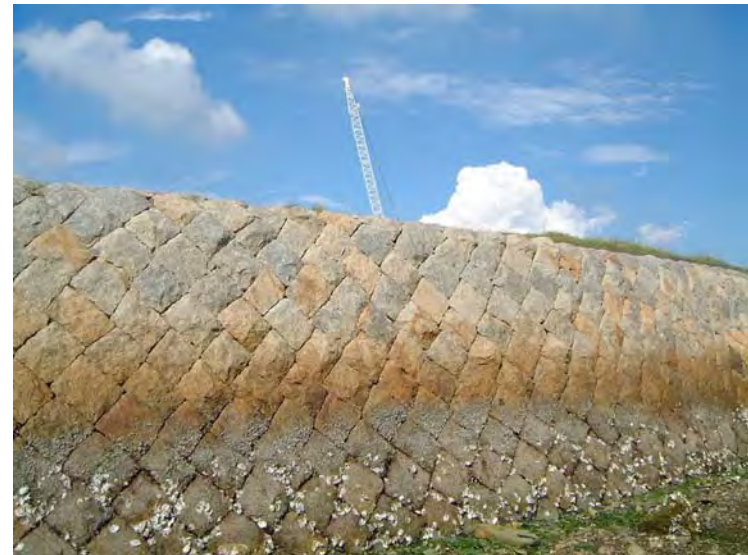
【護岸の補修後】
